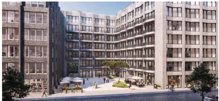
Leuchtturmprojekt für Smart Buildings: das BORX in Hamburg mit Wärmepumpe, PV-Anlagen, Eisspeicher und Betonkernaktivierung.
