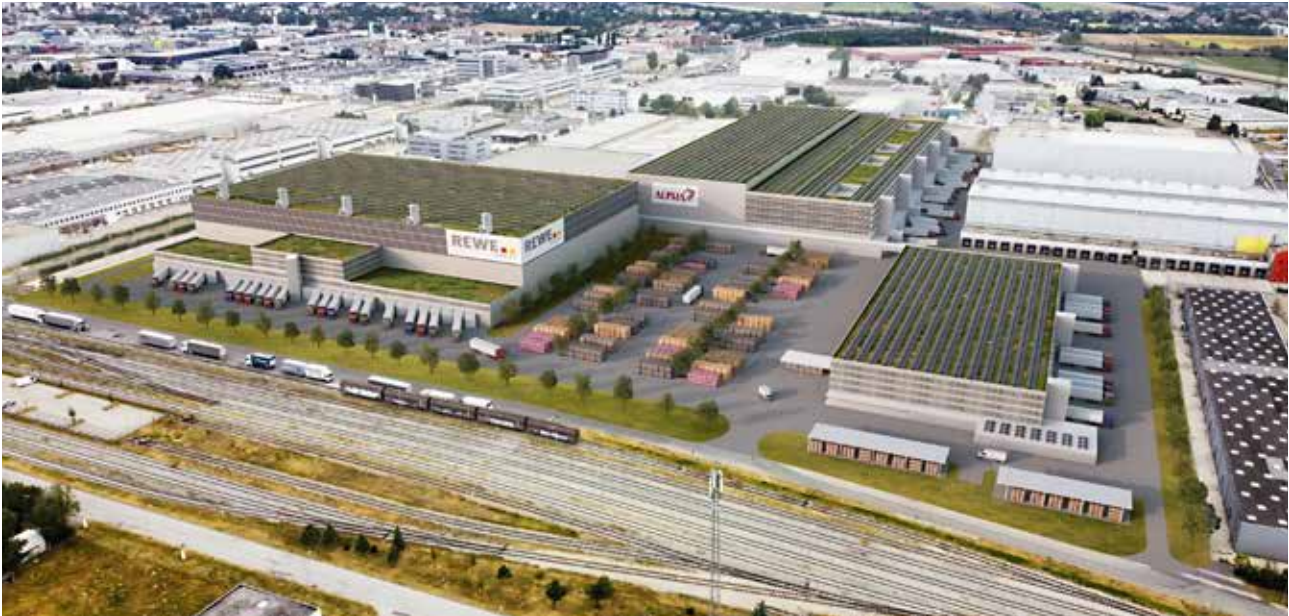
Auf 150.000 m 2 entsteht in Wiener Neudorf eines der modernsten Logistikzentren Europas: Vollautomatisiert, nachhaltig und zukunftsweisend.
